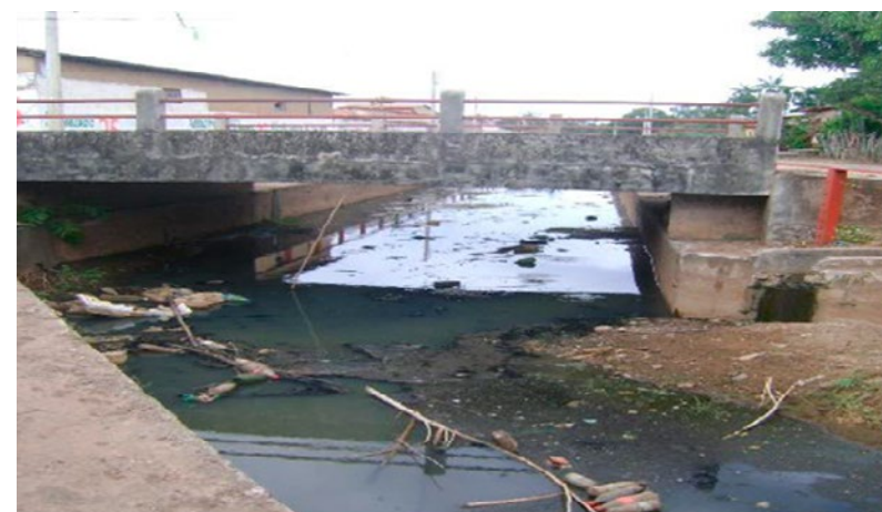
Figura 2: Lixo acumulado no Canal de Drenagem Pluvial do município de Pinheiro, Maranhão.
