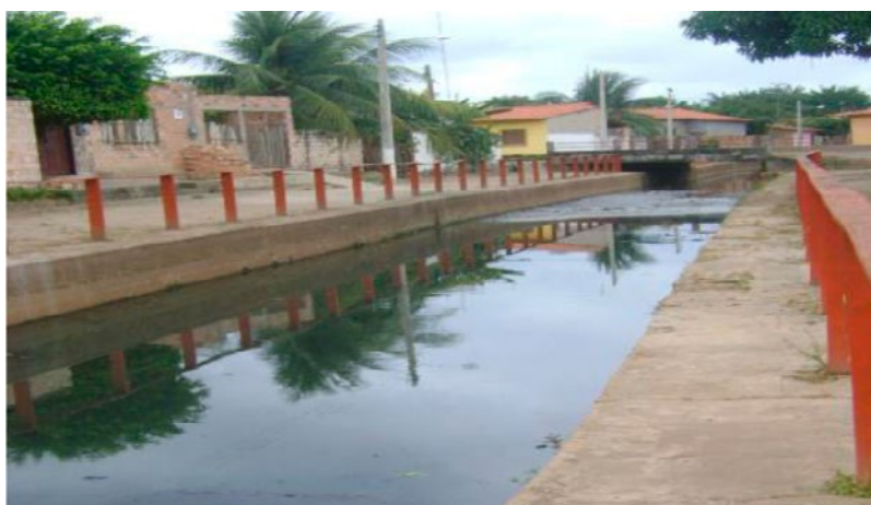
Figura 1: Canal de Drenagem Pluvial localizado no município de Pinheiro, Maranhão.
