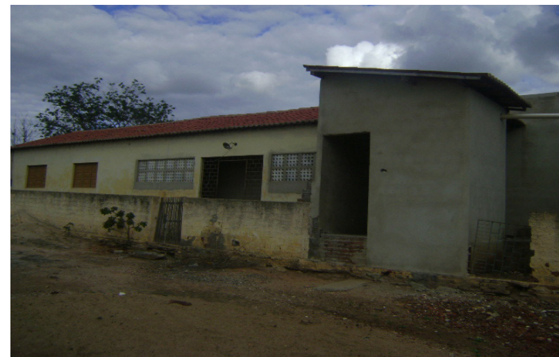
FIGURA 12: ESCOLA DA COMUNIDADE CAITITU QUE ESTAVA SENDO REFORMADA ANTES DA INSTALAÇÃO DO CONFLITO TERRITORIAL. REGISTRO REALIZADO EM DEZEMBRO DE 2016.
